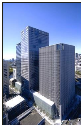
日経ビル・JAビル・ 経団連会館 全体共用部
