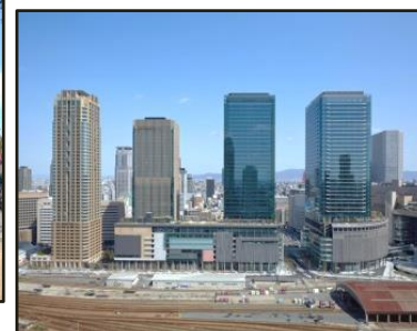
グランフロント大阪(北館)
