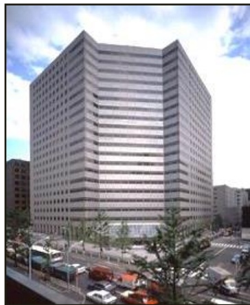
アーバンネット大手町ビル (撮影:三輪晃久写真研究所)
